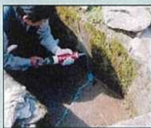
ひび割れの補修
