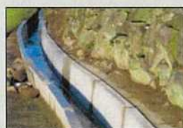
素堀り水路からの更新
