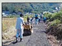
未舗装農道の舗装
