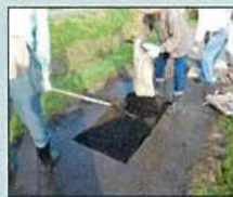
農道の部分補修
