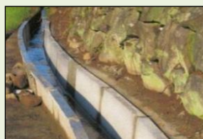
素堀り水路からの更新
