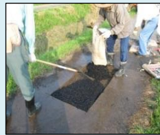
農道の部分補修
