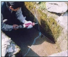
ひび割れの補修
