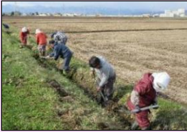
水路の泥上げ
