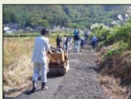
未舗装農道の舗装
